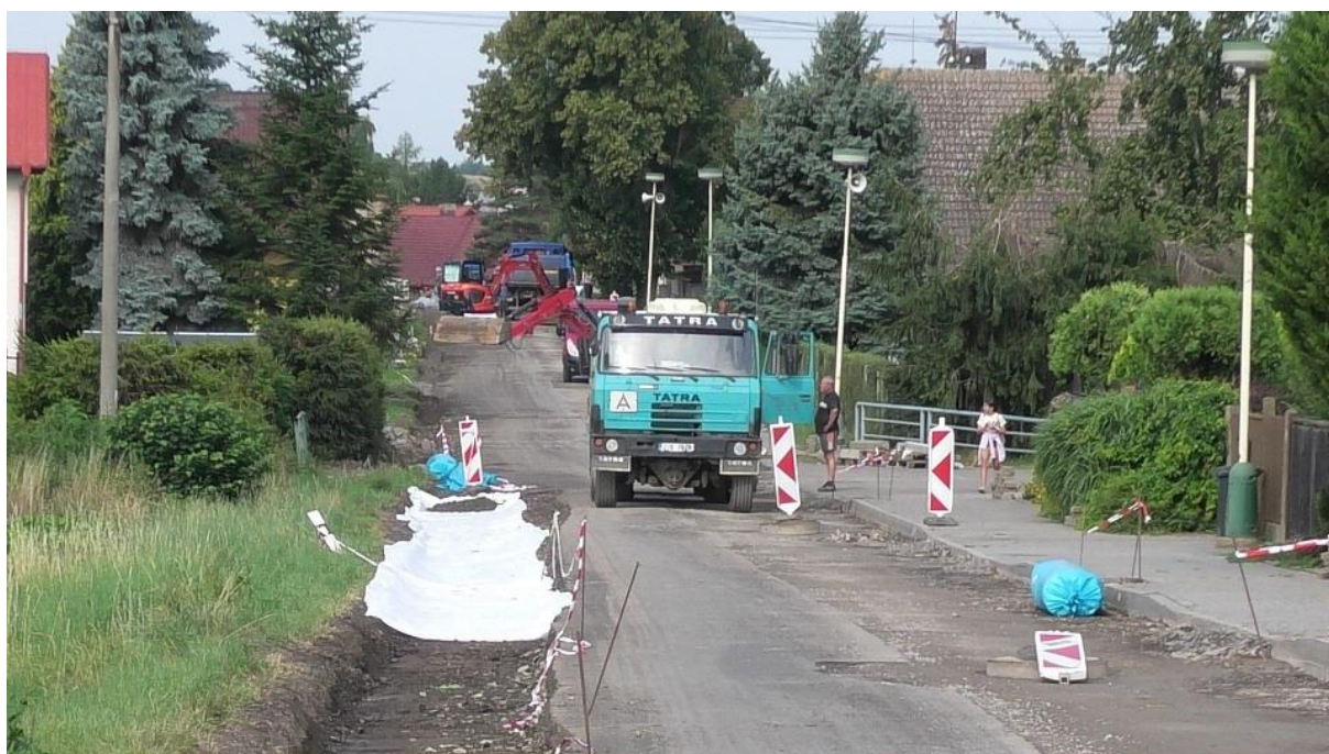
17.8.2023 oprava silnice po kanalizaci od Nabočan
